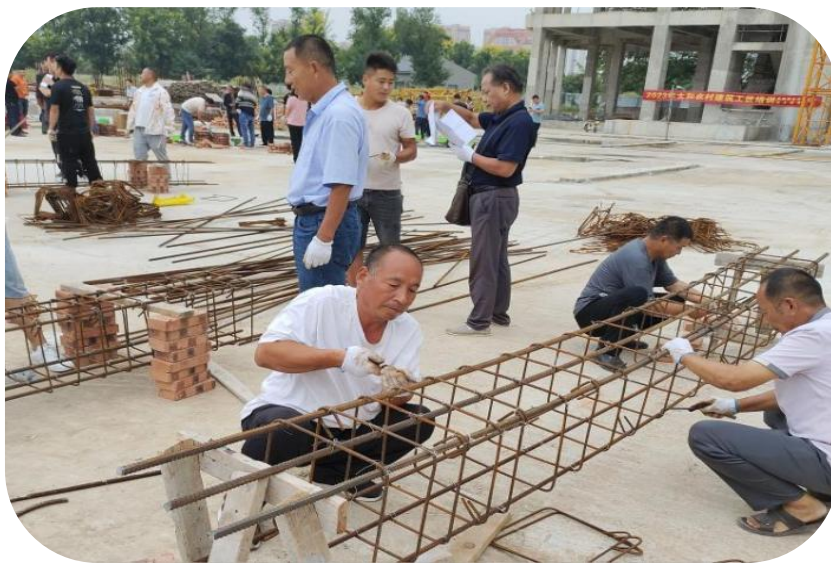
图 3-1 建筑专业教师为太和县建筑工匠钢筋工开展实操培训
